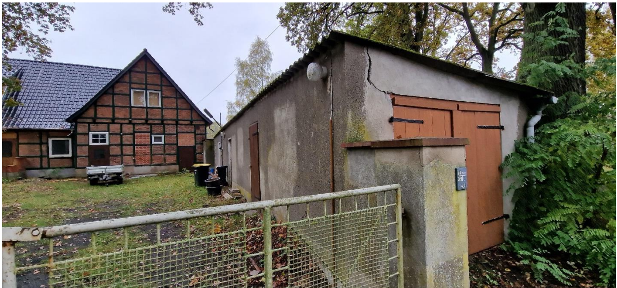
Abbildung 3 Blick von Osten in Richtung Westen auf einen Teil des ehemaligen Sportlerheims und eines der vorhandenen Nebengebäude, Foto St. Schulz, 28.10.2023
