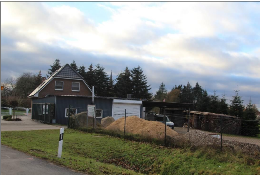
Abbildung 5: Ansicht des Wohngebäudes mit Nebengelassen.
